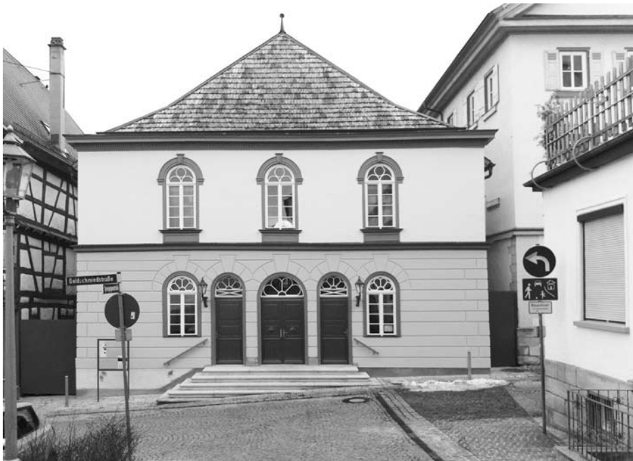
Die Alte Synagoge Hechingen 2019 nach der Renovierung der Außenfassade. Foto: Benedict von Bremen.
