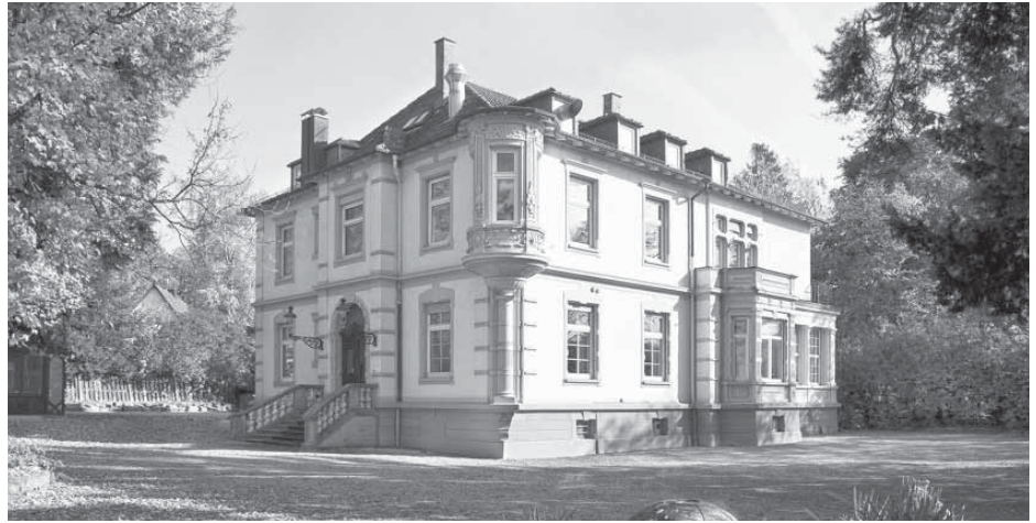
Villa Weise in Kirchheim
